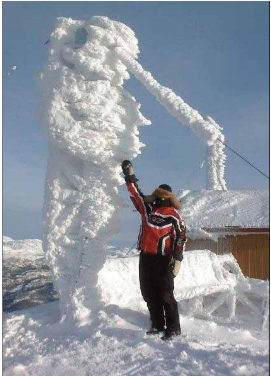
Jan Vidar Holte konstaterer mykje ising på linkstasjonen Rust i Åmotsdal. Trass i mykje is sender antennene som dei skal.
