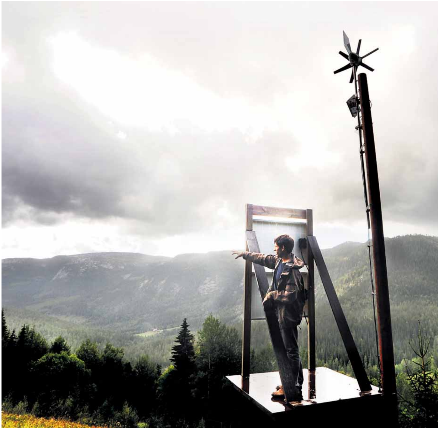
Turen: Fri sikt mellom topper og radiolinker må til for å få bredbånd fram til de mest avsidesliggende gårdene, forklarer Mikkel Aanderaa. Han har selv reist solcellepanelet og vindmølla som gir nødvendig strøm til linken.
